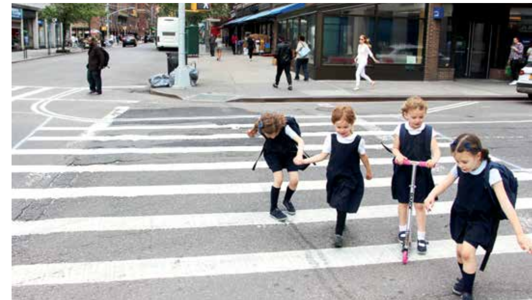
Esta travessia de pedestres em Greenwich Village, em Nova York, EUA, está demarcada para sua futura reformulação, que incluirá um avanço da calçada sobre a via, diminuindo assim a distância de travessia dos pedestres.
