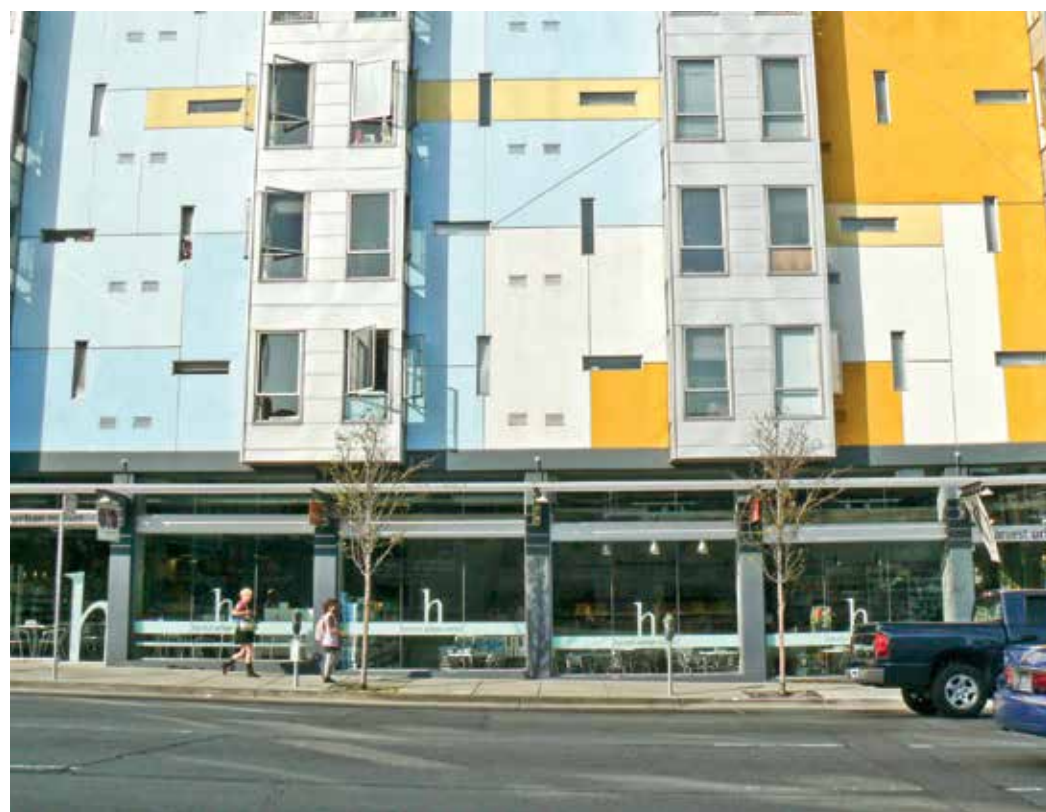
Este projeto implantado no bairro Soma de San Francisco, Califórnia, EUA, inclui habitação popular e usos comerciais com fachada ativa.
