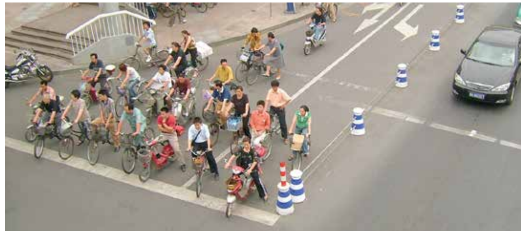
Uma ciclovia de alta capacidade conta com proteção física, faixas de conversão e uma linha de parada avançada para os ciclistas em Hangzhou, China.
